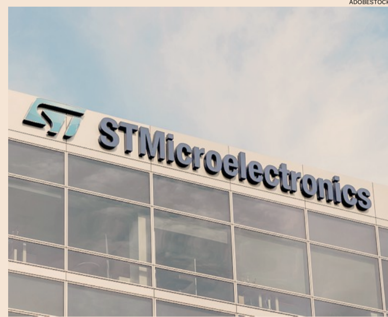
A Catania. Oggi la visita del ministro Adolfo Urso e della Commissaria Ue Margrethe Vestager al nuovo impianto di produzione di conduttori StMicroelectronics
